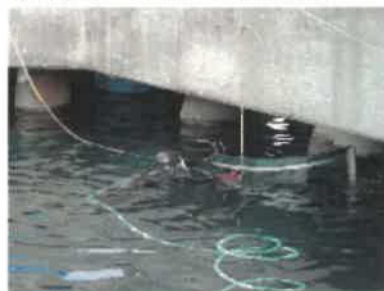
b ポリカーボネート型枠設置
