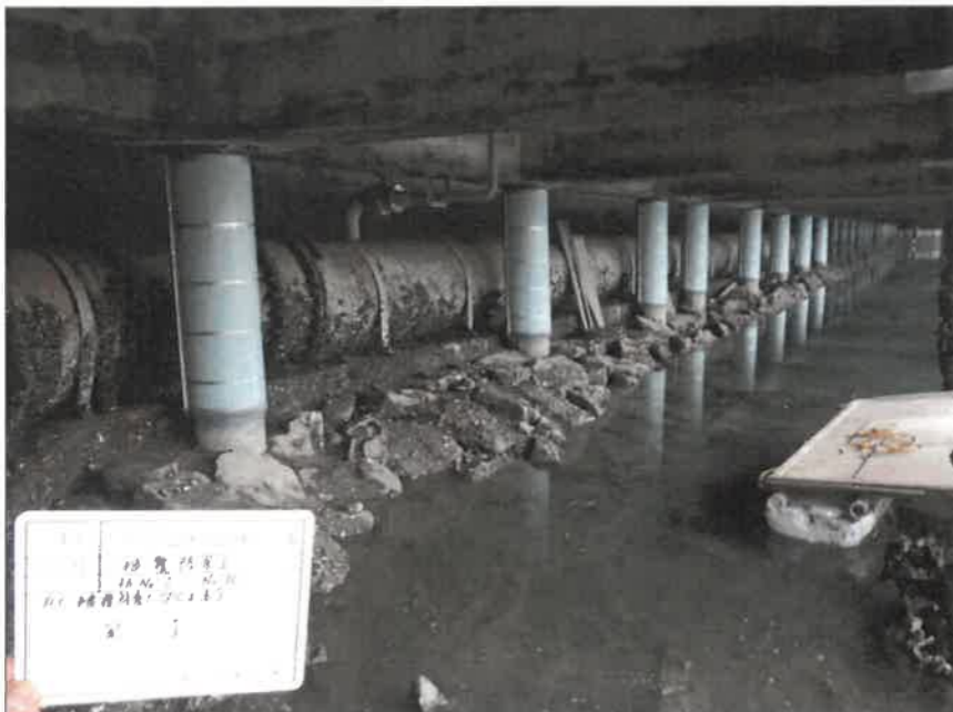
写真区分: 施工状況写真 工種: 被覆防食工 種別: PC被覆防食 細別: 防錆ペーストSACコ ート 写真タイトル: 注入・充填 完了 撮影箇所: 杭No. 1～10
